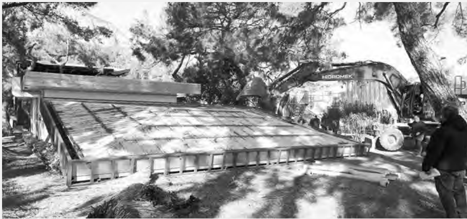
Yıkılan yapıların kalıntıları.
