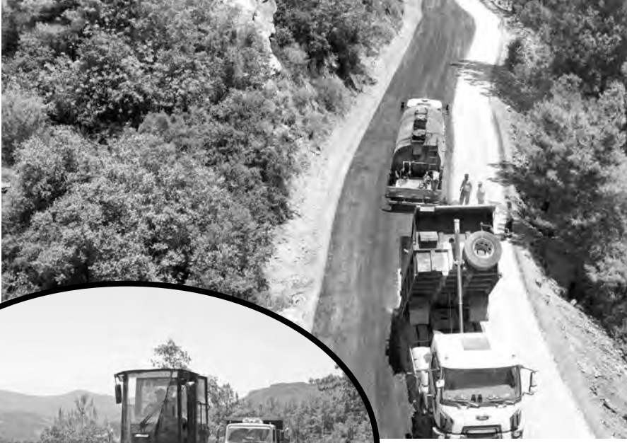
asfalt çalışması başlatıldı.
